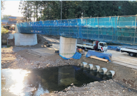
日高市／新堀橋
